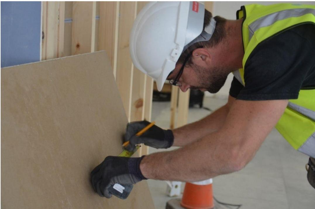
I ricercatori della start-up *Adaptavastate* sono da sempre impegnati nell'ideazione e nella realizzazione di materiali da costruzione sostenibili. Per realizzare il loro **cartongesso biodegradabile**, per esempio, utilizzano scarti dell'agricoltura anziché il tradizionale gesso: il materiale risulta così più leggero ma al contempo offre livelli di isolamento termico e sonoro maggiori rispetto al cartongesso tradizionale.
