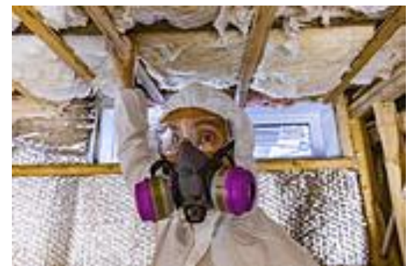
L'Esperto in Edificio Salubre agisce negli ambienti indoor inquinati da muffe, radon, concentrazioni tossiche, ecc.
