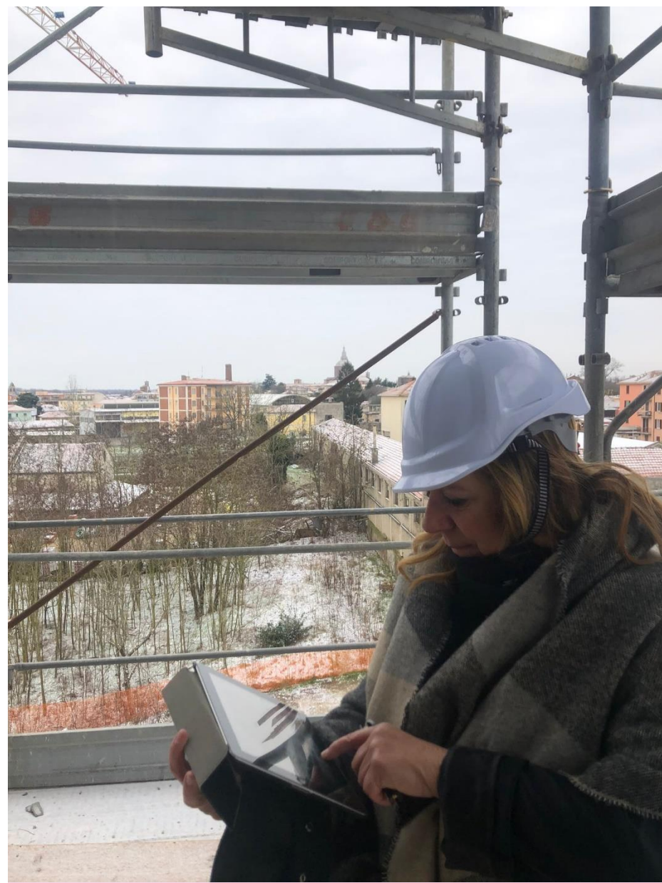
DONNE NELL'EDILIZIA: Un settore in crescita. Nella foto Loredana Bellagente in cantiere
