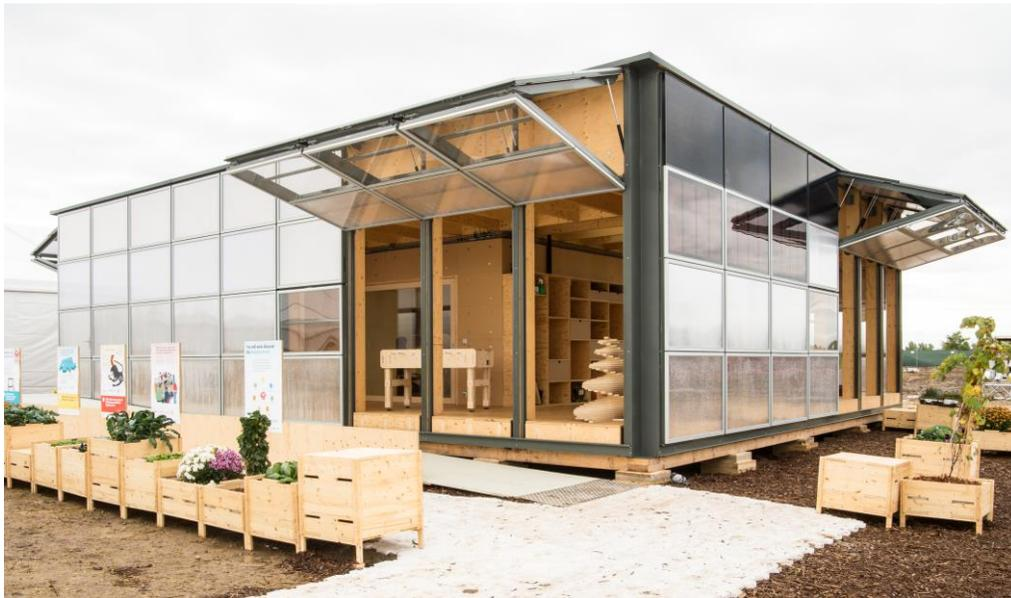
La casa è composta dall'Extended Skin, che termicamente funziona in modo passivo cioè lo spazio è ventilato in modo naturale e riscaldato grazie ai ricavi solari passivi e alle porte basculanti su tutte le facciate. Questo spazio semi esterno permette di proteggere dalla neve e dalla pioggia.
