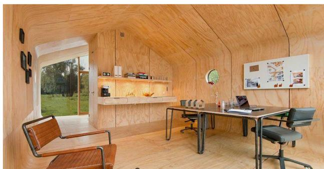
La resistenza della Wikkelhouse, è garantita dal cartone con il quale viene realizzata: **24 strati per l'esattezza**, tutti di cartone di alta qualità. Questo rivestimento viene avvolto attorno ad un telaio 'a forma di casa', per poi essere fissato con una **supercolla eco-fiendly** e rivestito successivamente con una pellicola resistente alla
